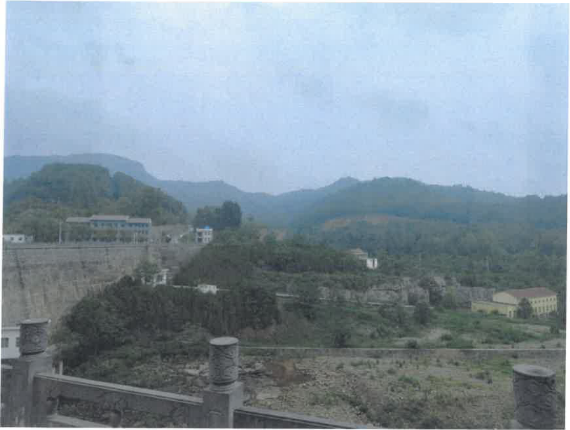
西冶水电站全景
