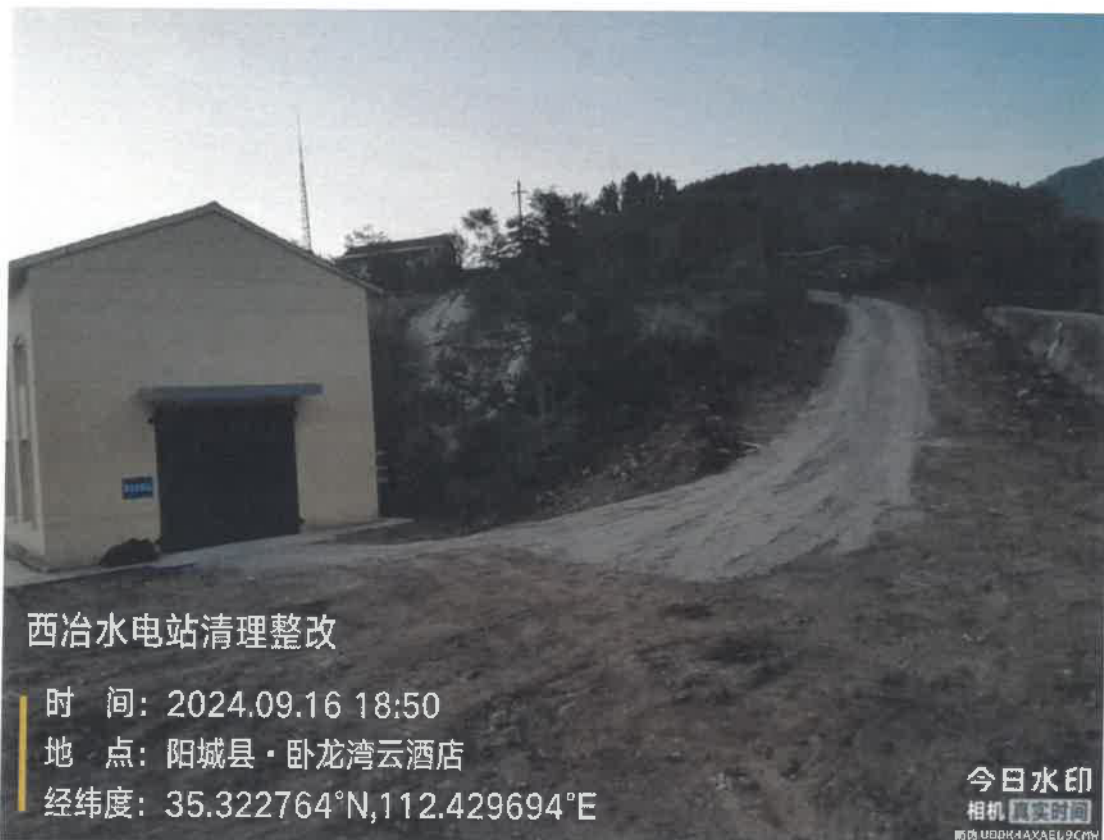
西冶水电站厂房及周边道路整改后照片
