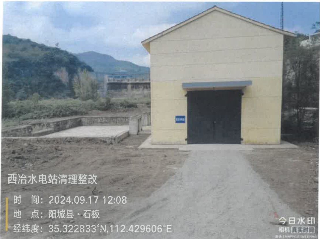
西冶水电站厂房整改后照片
