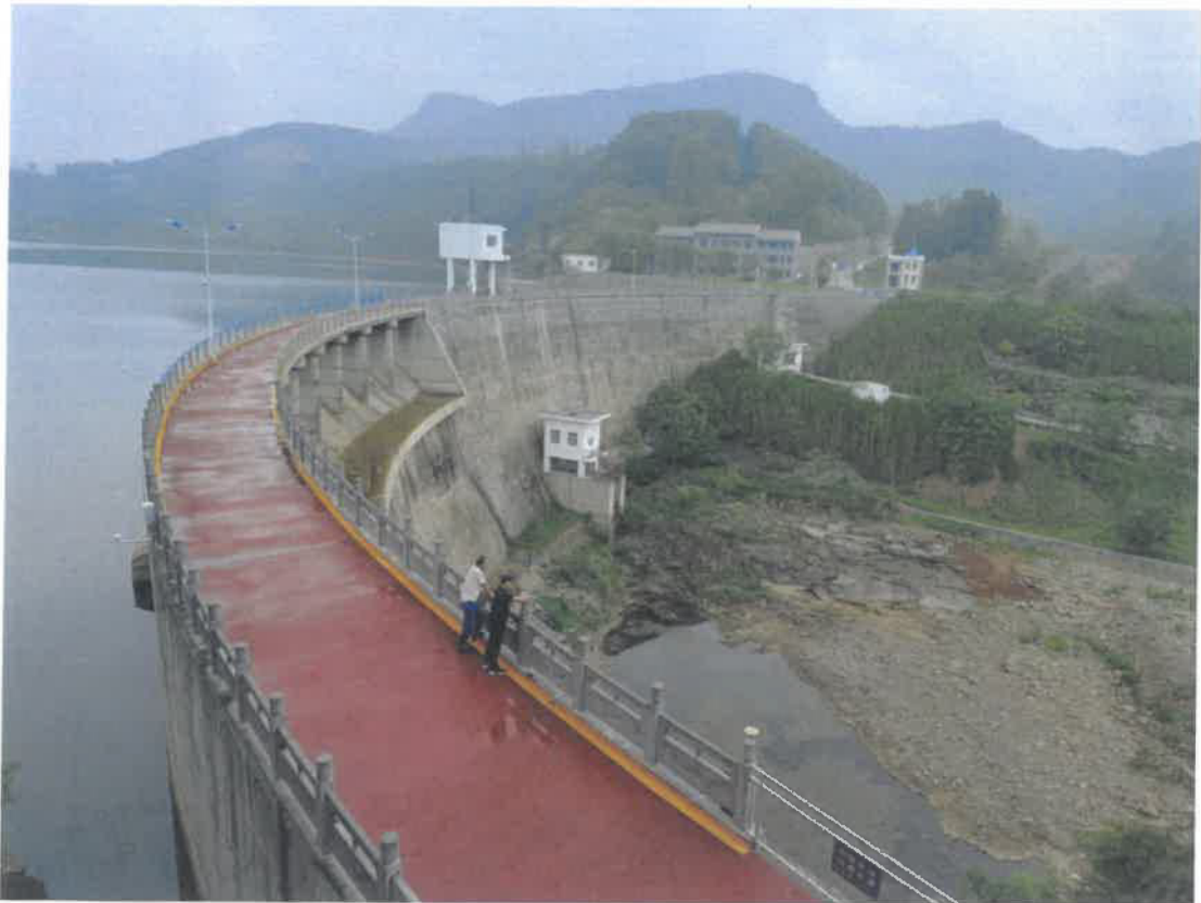
西冶水电站大坝枢纽工程
