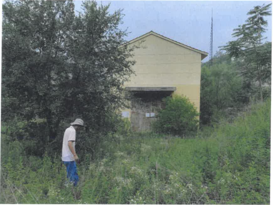
西冶水电站厂房整改前照片
