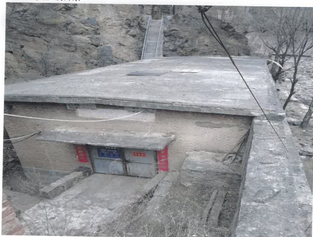
杜甲水电站厂房外景
